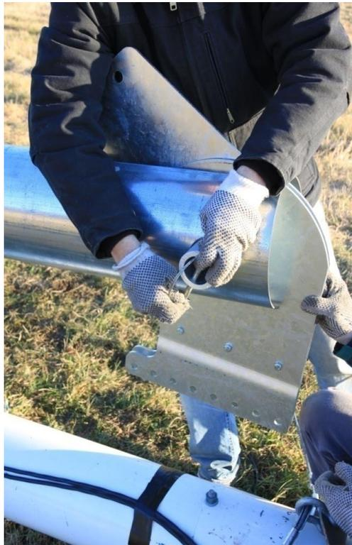
Picutre 3-55: Secure ginpole rocker plate pivot pipe
