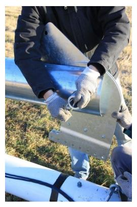
Picutre 3-55: Secure ginpole rocker plate pivot pipe
